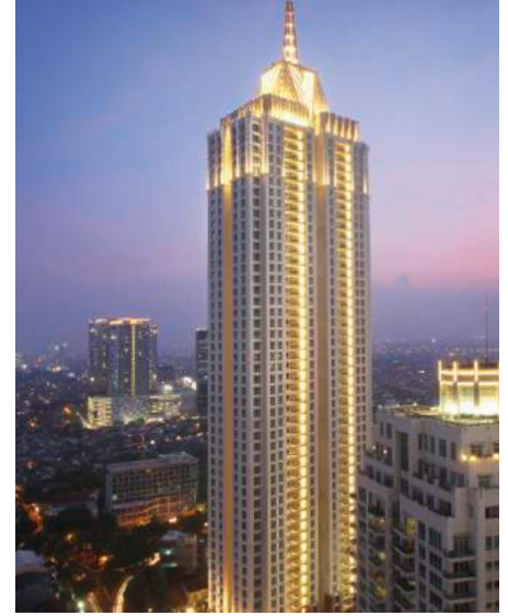
The Pakubuwono, Jakarta: Metris S 100 tek kollu lavabo bataryası, Metris S tek kollu duş bataryası, Raindance S 150 Air 3jet el duşu. Telif hakkı The Pakubuwono
